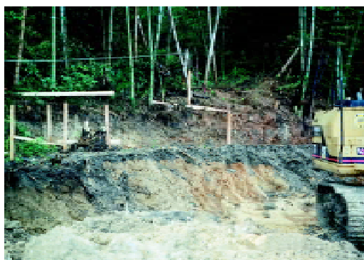
5. 4号窯付近の工事状況
