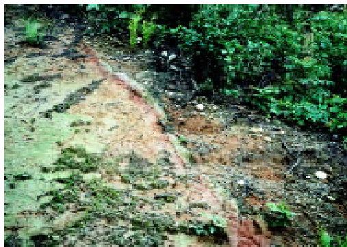
8. 破壊された7号窯の様子
