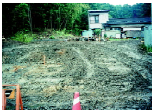
6. 9号窯付近の工事状況
