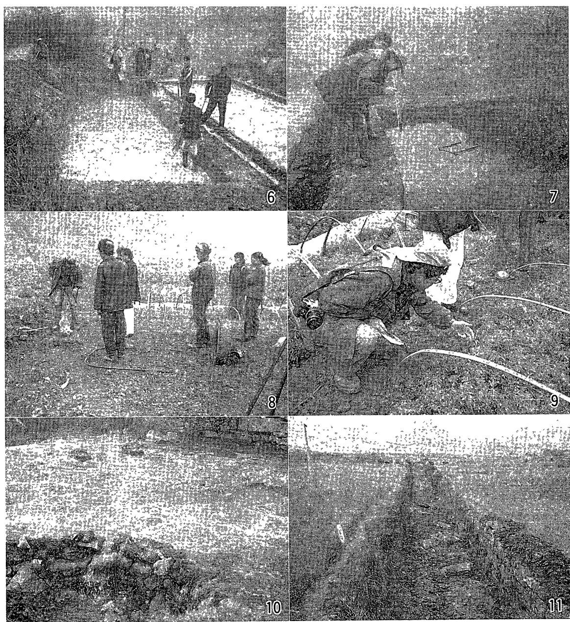
図6 テンブン製造工程の沈殿池より排水する水を処理するための酸化池の掘削
